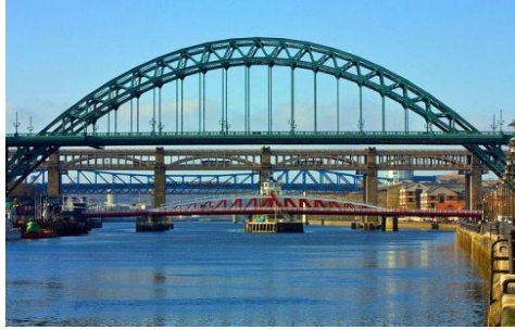
Ponts sur le fleuve Tyne, Newcastle
